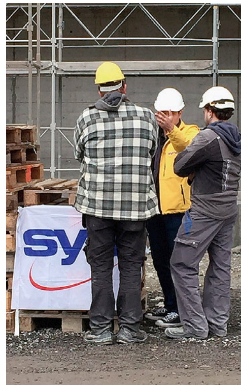
Regel Betrieb auf der Mall-Baustelle.
